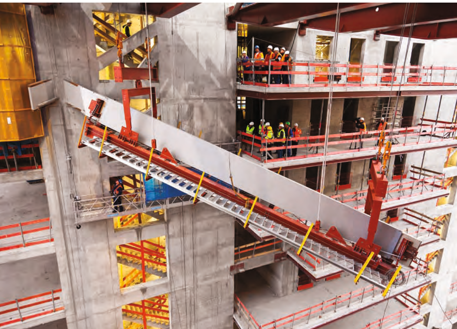
Nel novembre 2011 è stata installata la prima di 14 travi in acciaio nell'atrio; insieme alle piattaforme di interscambio, le travi serviranno a collegare le due torri di uffici.
