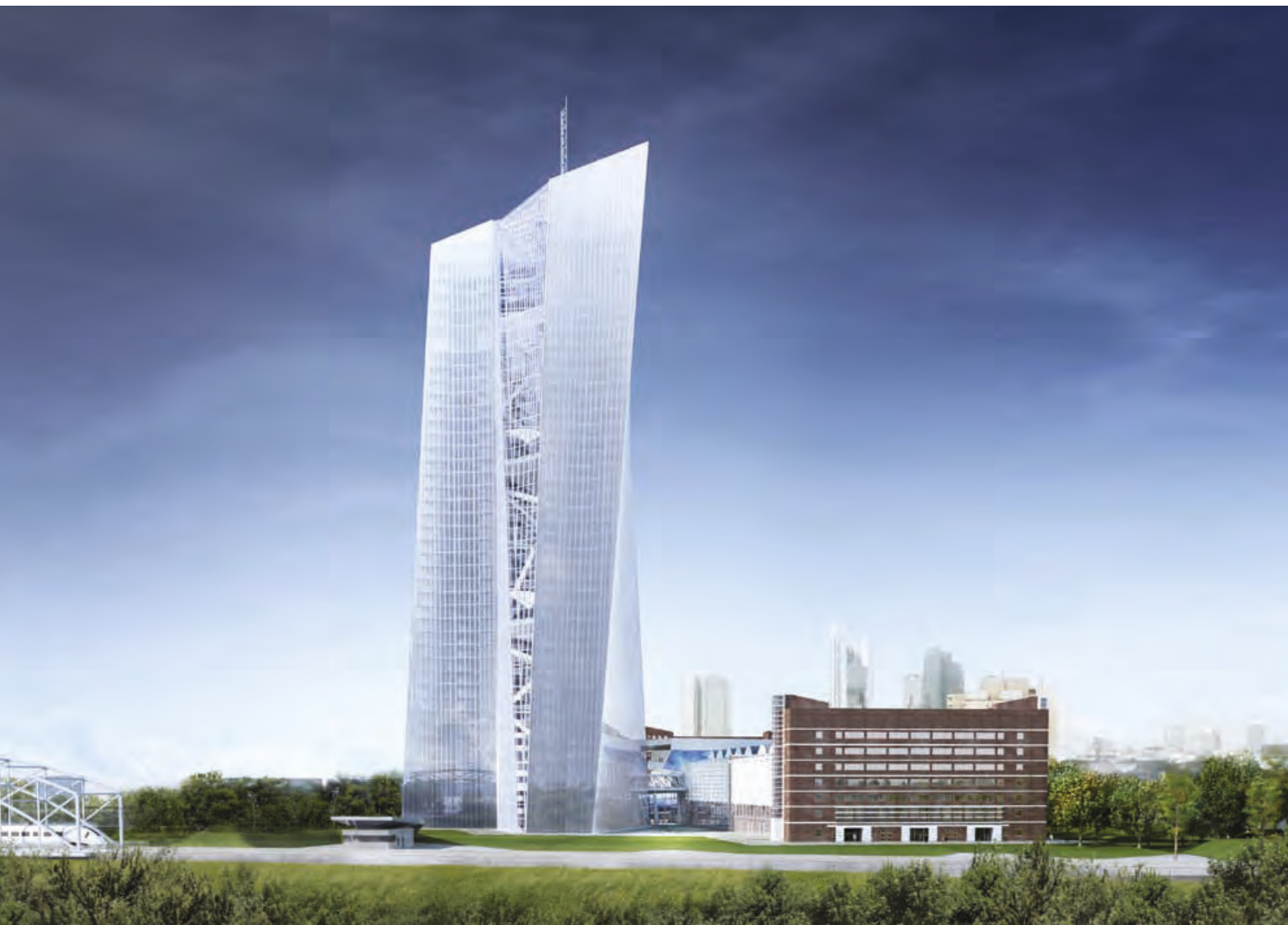
Nuova sede della BCE (lato est) – La nuova sede della BCE, attualmente in costruzione su progetto di COOP HIMMELB(L)AU, sarà costituita da tre elementi architettonici principali: una doppia torre di uffici, la Grossmarkthalle e un edificio di accesso. Il completamento dei lavori è previsto entro la fine del 2013.
