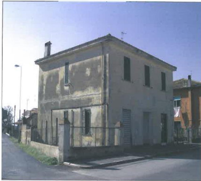
Agenzia di Braccagni prima della ristrutturazione
