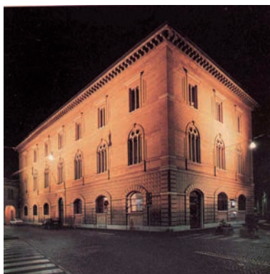
Cesena, Forlì-Cesena Palazzo della Cassa Cassa di Risparmio di Cesena Corso Garibaldi, 18
