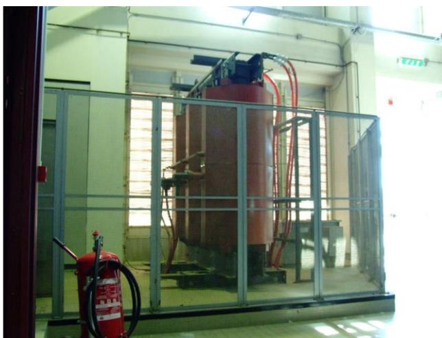
Foto 2.8 : Particolare del trasformatore a servizio della package
