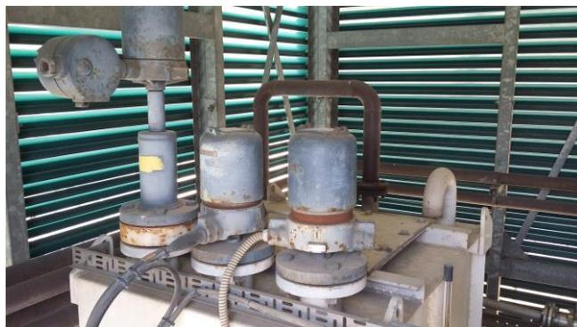
Foto 5.2 : Particolare del serbatoio "giornaliero" del gasolio e relativa strumentazione
