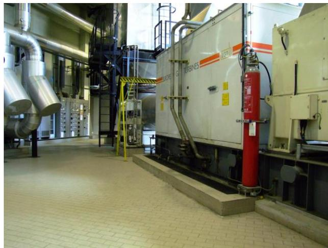
Foto 3.2 : Vista complessiva del turbo generatore con dettaglio della parte “iniziale” della caldaia a recupero e altri particolari
