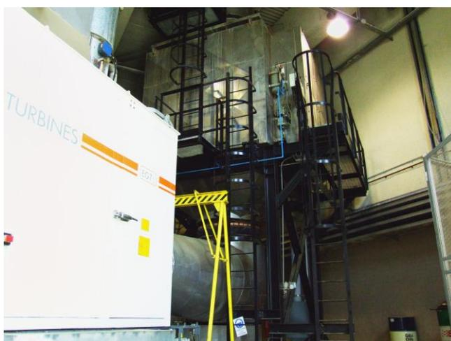
Foto 3.5 : Vista di assieme della cabina insonorizzata di macchina
