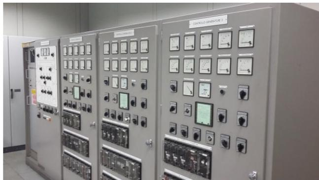
Foto 4.2 : Particolare dei quadri elettrici di controllo delle package di generazione
