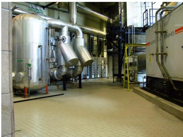
Foto 3.7 : Particolare dei vasi di espansione e del manifold di mandata delle pompe di alimentazione dell'acqua industriale (sul fondo i quadri MCC)
