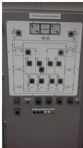
Foto 4.3 : Particolare del quadro di sincronizzazione con la rete elettrica
