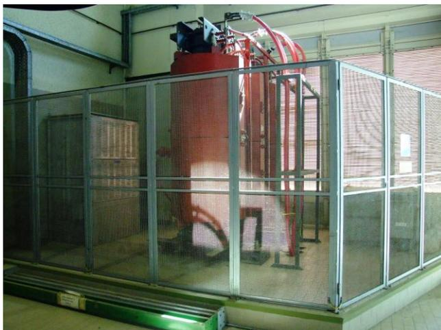
Foto 3.6 : Particolare del trasformatore a servizio della package
