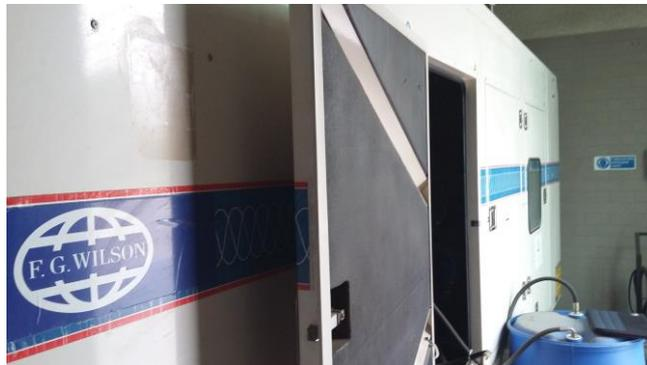
Foto 4.4 : Particolare della cabina insonorizzata relativa al gruppo di soccorso elettrico della centrale di cogenerazione
