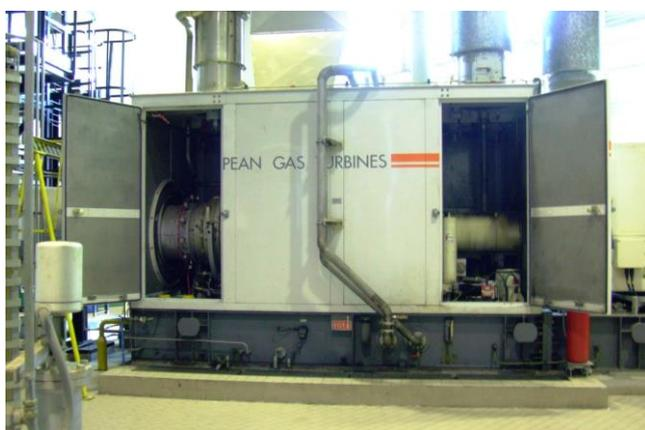
Foto 3.4 : Vista di assieme della cabina insonorizzata di macchina
