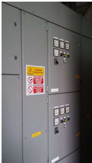
Foto 4.5 : Particolare del quadro di “scambio” gruppo di soccorso elettrico –rete centrale
