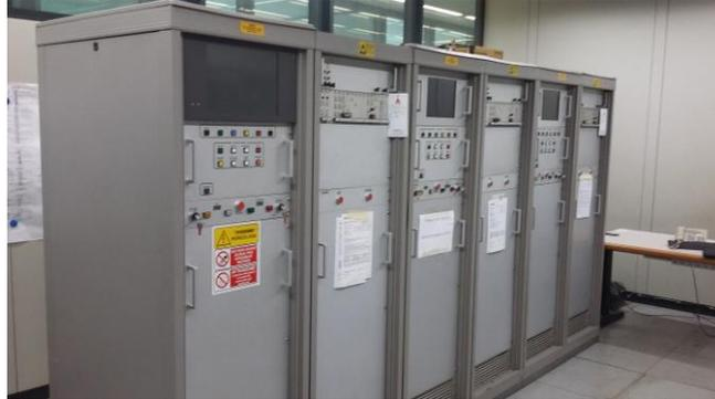
Foto 4.1 : Particolare dei quadri elettrici completi di sistemi PLC di comando e controllo
