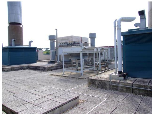
Foto 5.2 : Particolare dei sistemi di raffreddamento dell'olio lubrificante, comune ad ogni package di generazione
