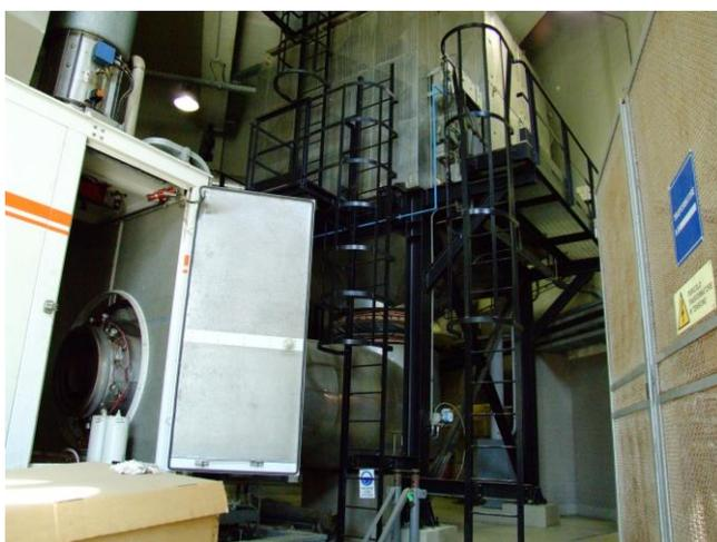
Foto 2.7 : Particolare Caldaia a recupero e strutture accessorie
